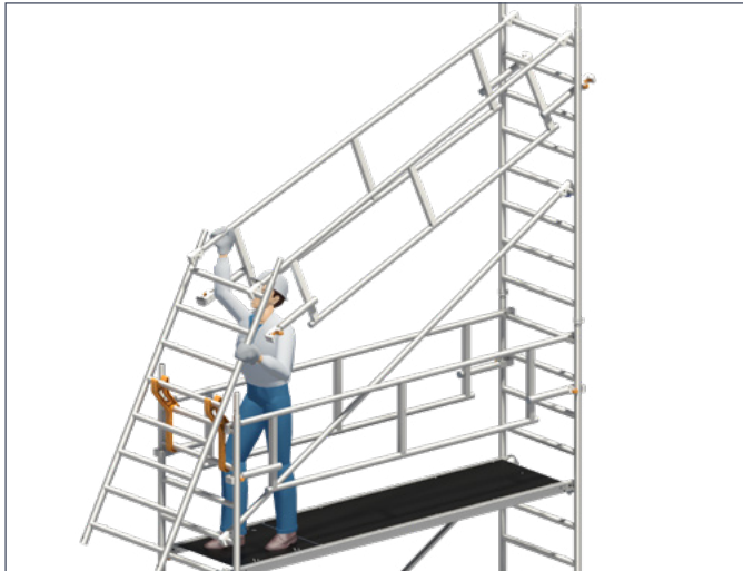
1. Aufstecken der ersten Standleiter. Anbringen der Uni Montagehaken und Positionierung der zweiten Standleiter zur Montage des Doppelgeländers auf beiden Seiten.
